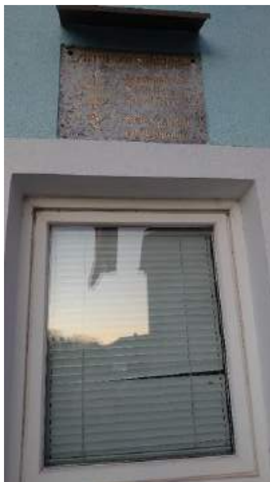
Priloga N2: Spominska plošča godbenikom
